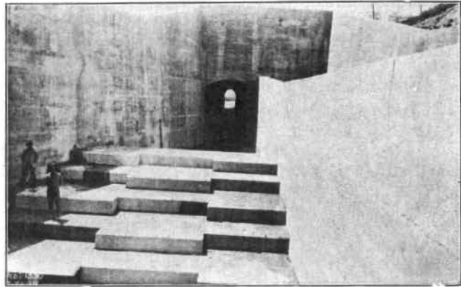
FIG. 160—OUTLET OF SOUTH CONDUIT
