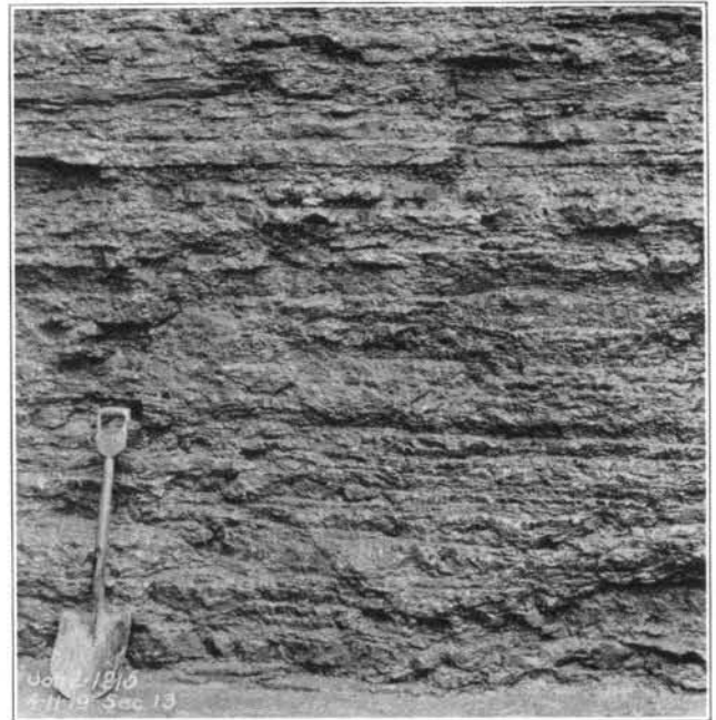
FIG. 136—ENGLEWOOD ROCK EXCAVATION
